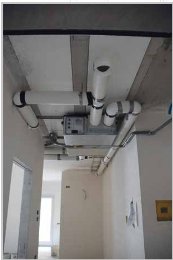
REALIZZAZIONE IMPIANTO E ALLACCIAMENTO IDRAULICO
