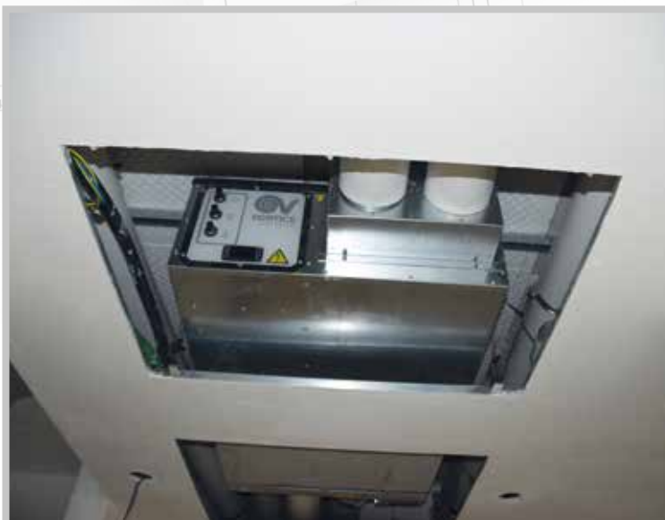
REALIZZAZIONE BOTOLA ISPEZIONE
