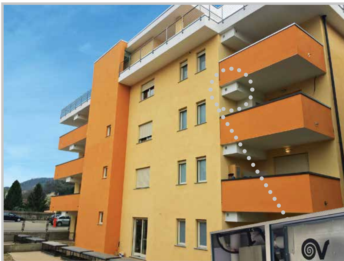
Alloggiamento del recuperatore di calore e della batteria di post trattamento idronico.
